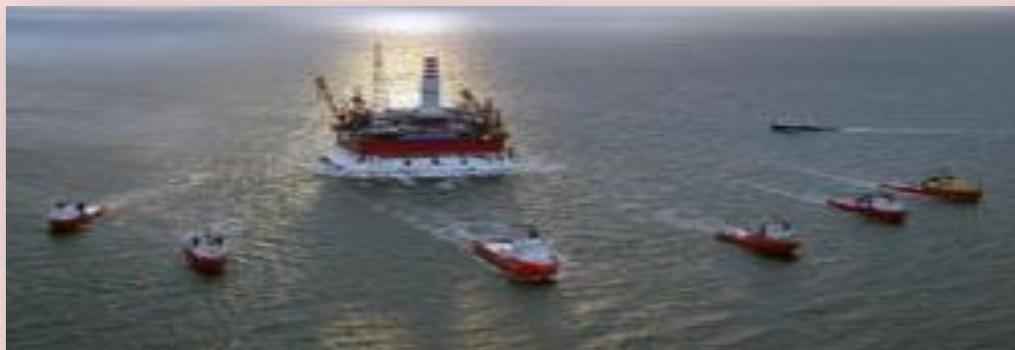
Это гигантское сооружение (масса МЛСП без твердого балласта – 117 тысяч тонн) с 1995 года строилось на «Севмашпредприятии» и представляет собой *уникальное сооружение* гравитационного типа, обеспечивающее бурение промышленных скважин, добычу, первичную обработку, хранение и отгрузку углеводородного сырья на танкеры.<sup>1</sup>
