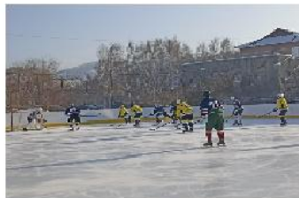
Обустройство хоккейной коробки
