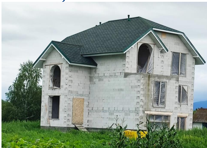
Строительство нового дома в с. Старобелокуриха Алтайского района
