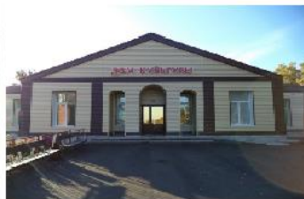
Ремонт дома культуры
