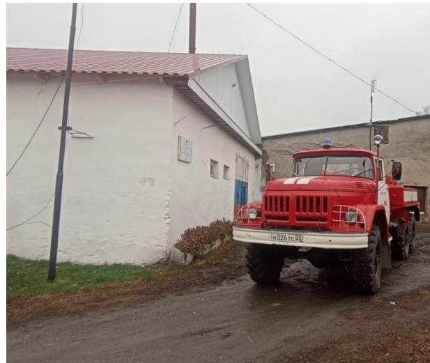
Ремонт здания пожарной части, Быстроистокский район
