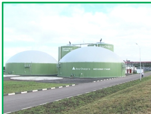
Строительство биогазовых станций
