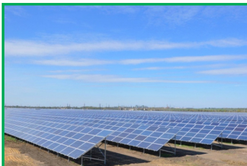
Строительство солнечных электростанций
